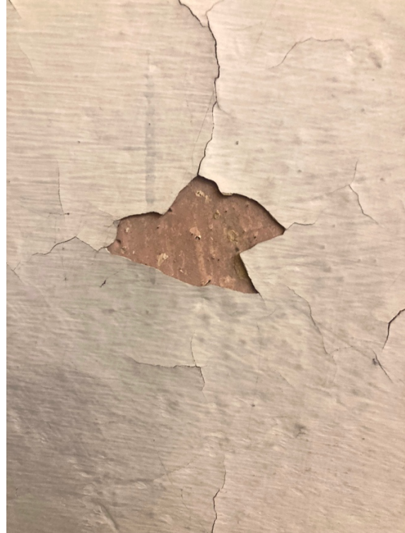
Fot. 15/16 Fragment ściany nawy bocznej z widocznymi pęknięciami i odspojeniami farby dyspersyjnej, stan przed konserwacją.
