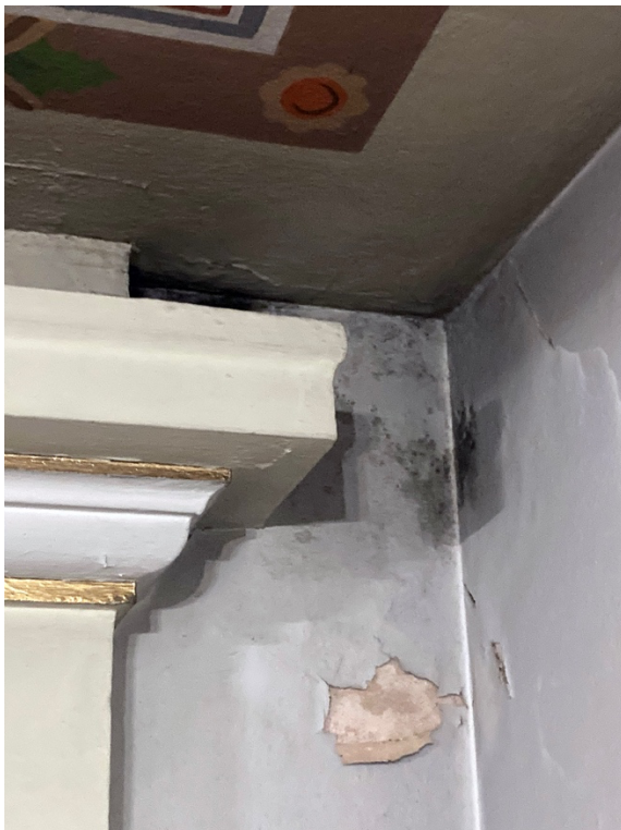
Fot.17/18 Widok na fragment ściany przy cokole filaru, ściana nawy bocznej. Przebarwienia zaistniałe w wyniku procesów mikrobiologicznych oraz wykwitły soli na odsłoniętym fragmencie ściany - zdj. 17, stan przed konserwacją.
