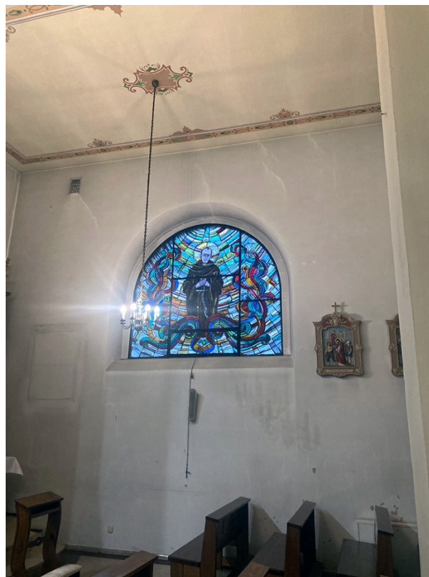
Fot.14 Widok na fragment ściany nawy bocznej – stan przed konserwacją.
