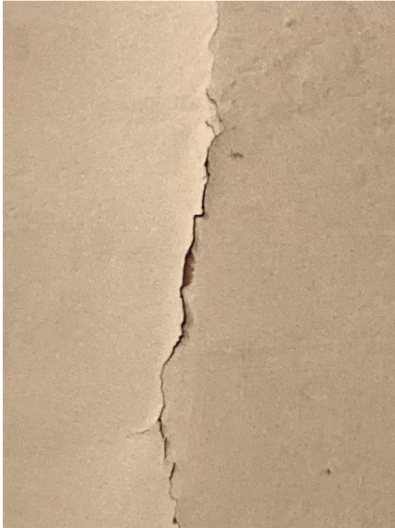
Fot. 15/16 Fragment ściany nawy bocznej z widocznymi pęknięciami i odspojeniami farby dyspersyjnej, stan przed konserwacją.
