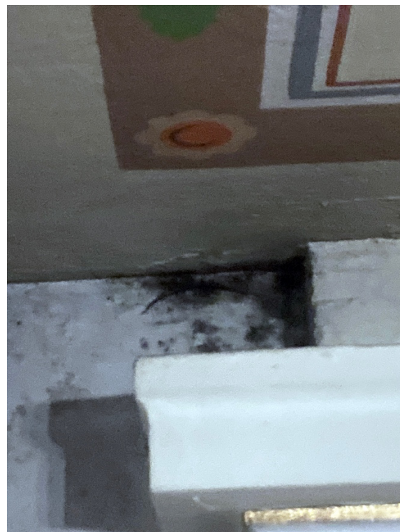
Fot.17/18 Widok na fragment ściany przy cokole filaru, ściana nawy bocznej. Przebarwienia zaistniałe w wyniku procesów mikrobiologicznych oraz wykwitły soli na odsłoniętym fragmencie ściany - zdj. 17, stan przed konserwacją.
